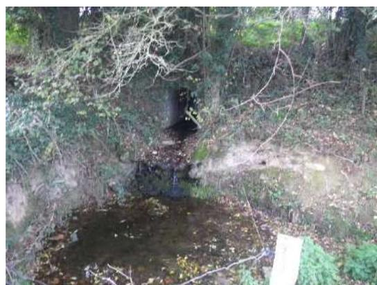
Ouvrage de franchissement (pont voute) problématique avec une chute conséquente sur ruisseau sur la Borderie
