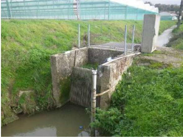
Ouvrages de régulation hydraulique
