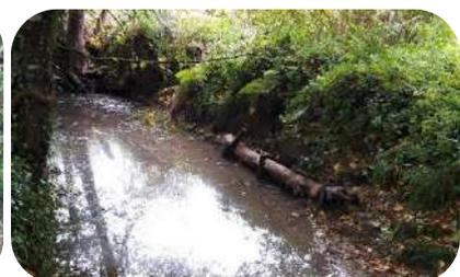
Le résultat n'est pas concluant, la fixation des troncs n'a pas résisté aux hautes eaux et aux débits hivernaux. Si la technique reste intéressante, sa mise en œuvre exige un bon savoir-faire. Les matériaux utilisés doivent également faire l'objet d'une attention particulière (troncs suffisamment gros et pourvus de branches perpendiculaires).
