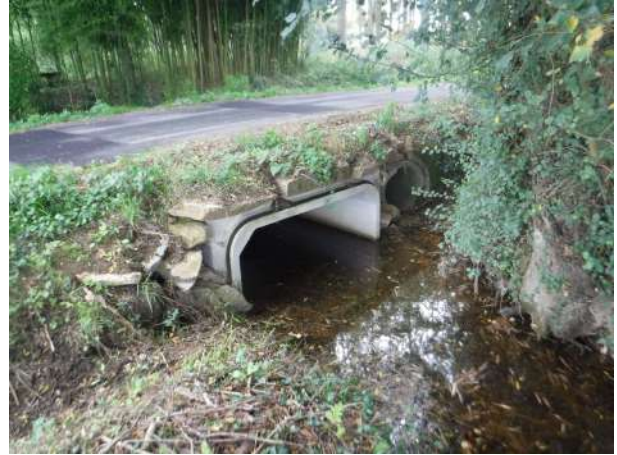
Pont cadre sur le Poyet bien calé
