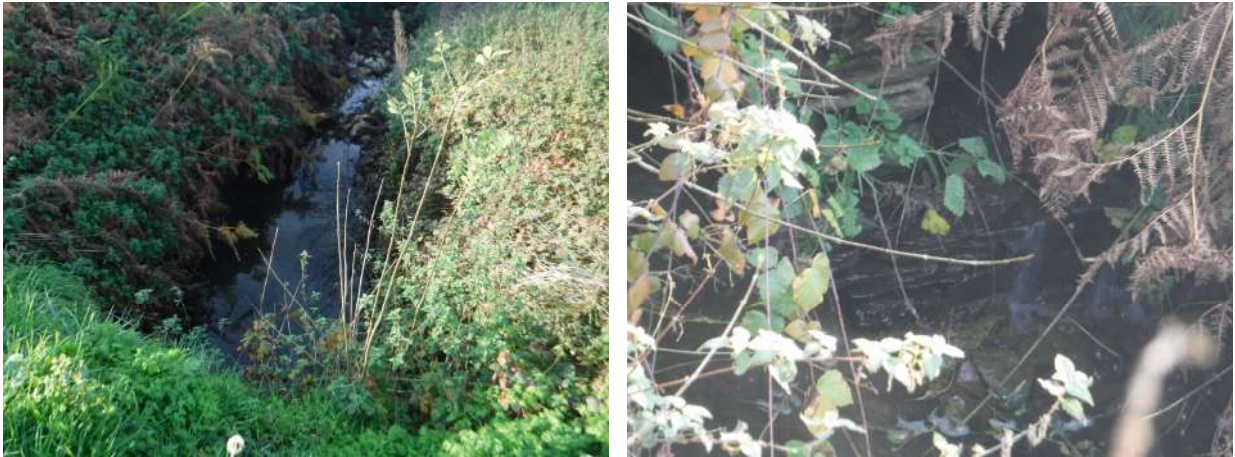
Mise en place d'une recharge en granulats en aval d'un pont sur la Boisardière
