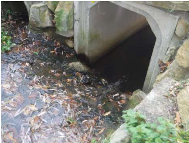
Pont cadre sur le Poyet bien calé
