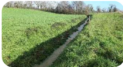
La Fennetière (avant travaux)
