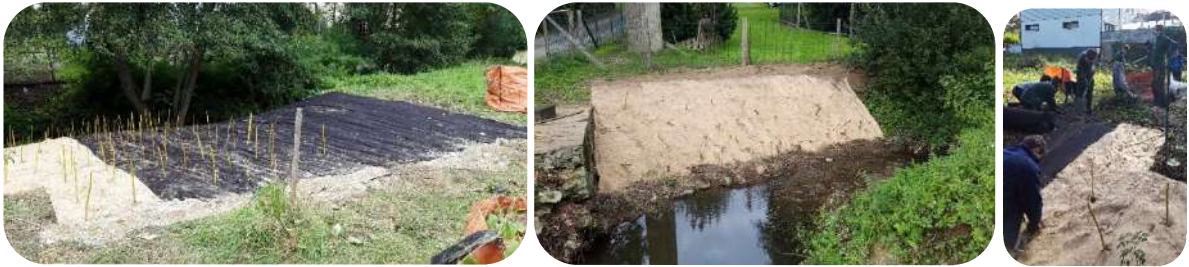
Arrachage de pousses de Renouée d Japon, pose d'une toile de jute et plantation de boutures de saule
