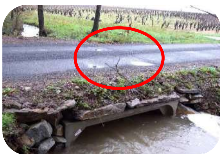
Affaissement d'enrobé de voirie en mai 2020 (Vallet)
