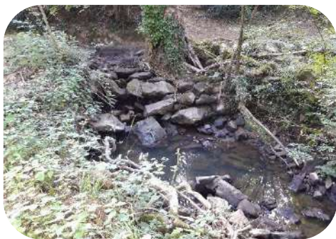
Le Beauchêne avant travaux
