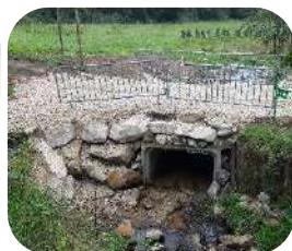
Reprise des berges et confortement de l'ouvrage (sept 2020)
