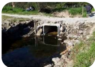
Erosion des berges de l'ouvrage (mars 2020)
