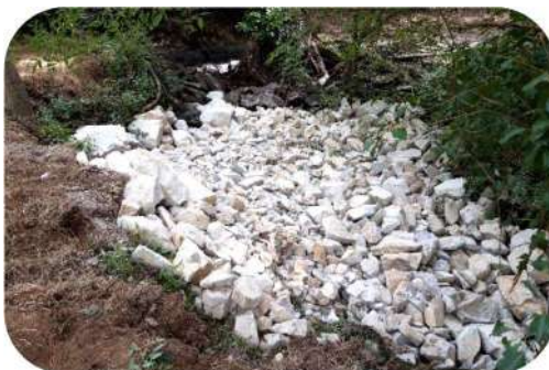
Le Beauchêne après travaux
