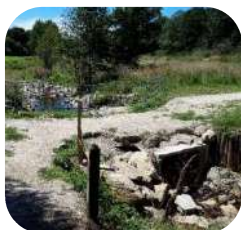
Erosion des berges de l'ouvrage (mars 2020)
