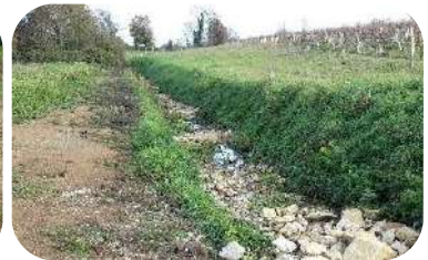
La Fennetière (3 mois après travaux)
