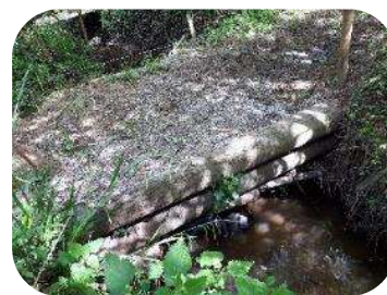
Ouvrage du Drouillet
