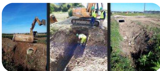
Travaux sur le Beau Chêne (remplacement de buse par un pont cadre)
