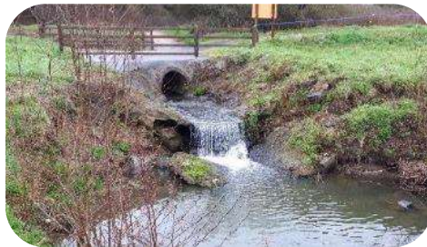
Ouvrage de la Boisardière
