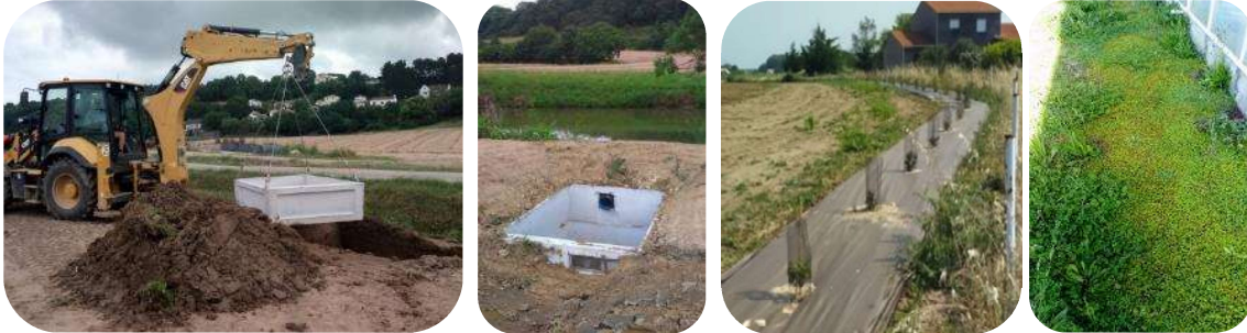
Travaux réalisés le long du Canal des Bardets (réalisation FMN)
