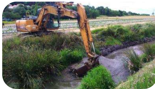
Travaux de retrait de de sable dans le Canal des Bardets (réalisation FMN)
