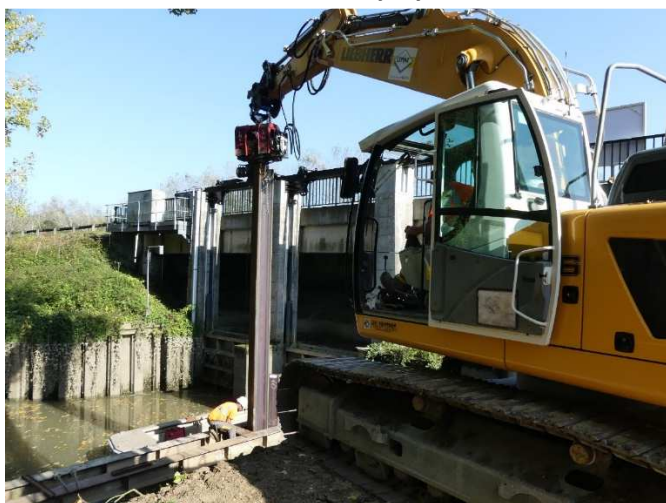
Travaux 2018: Installation des palplanches:
