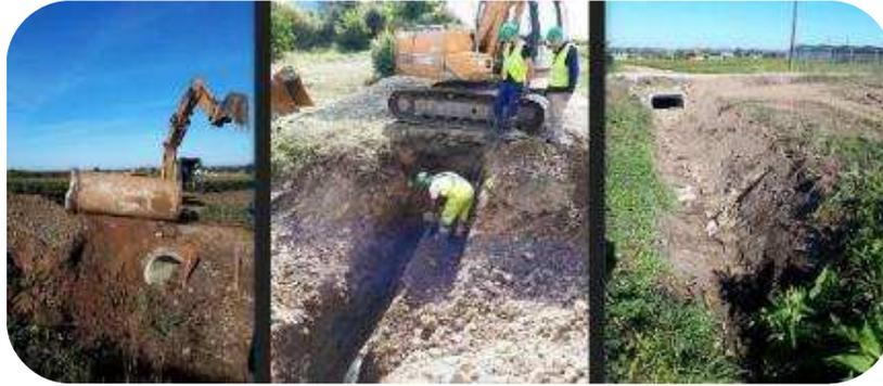
*Travaux sur le Beau Chêne (remplacement de buse par un pont cadre)*
