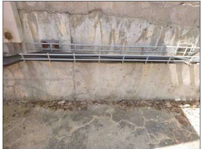
Photo 36 : Faiençage généralisé en partie basse du voile côté Loire rive gauche
