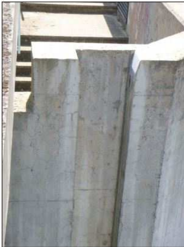
Photo 20 : Faiençage généralisé du bajoyer face intérieure rive gauche
