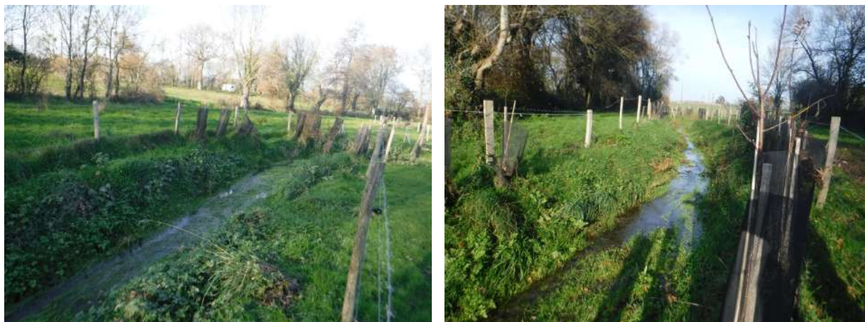
Reméandrage sur le Breil
