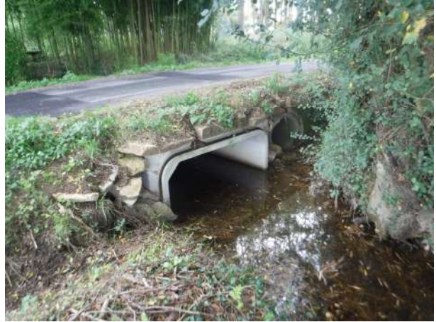
Pont cadre sur le Poyet bien calé
