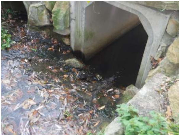
Pont cadre sur le Poyet bien calé
