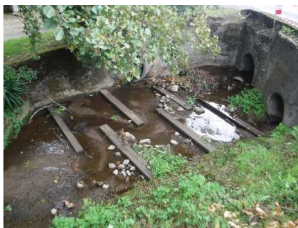
A gauche : déflecteurs sur le Bardou, et à droite : sur la Petite Noue
